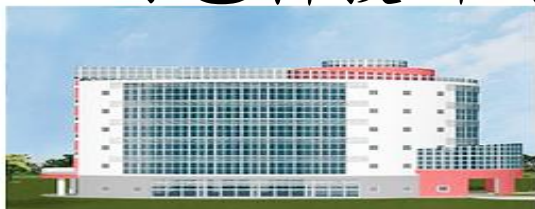
太陽能光電板/行政大樓
